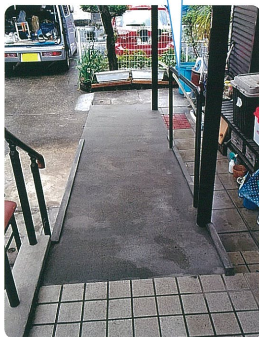
ポーチ側から見たスロープ
